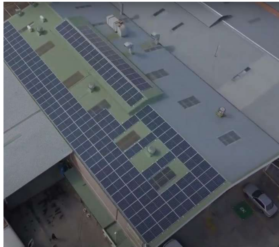
Paneles instalados Sede UIT
